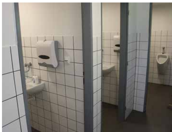
Nové sociální zařízení v provozní budově TJ
