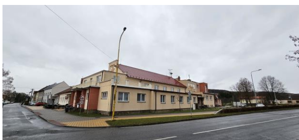
Obrázek 9: Budova objektu – Obecní úřad + KD + kavárna č.p. 400
