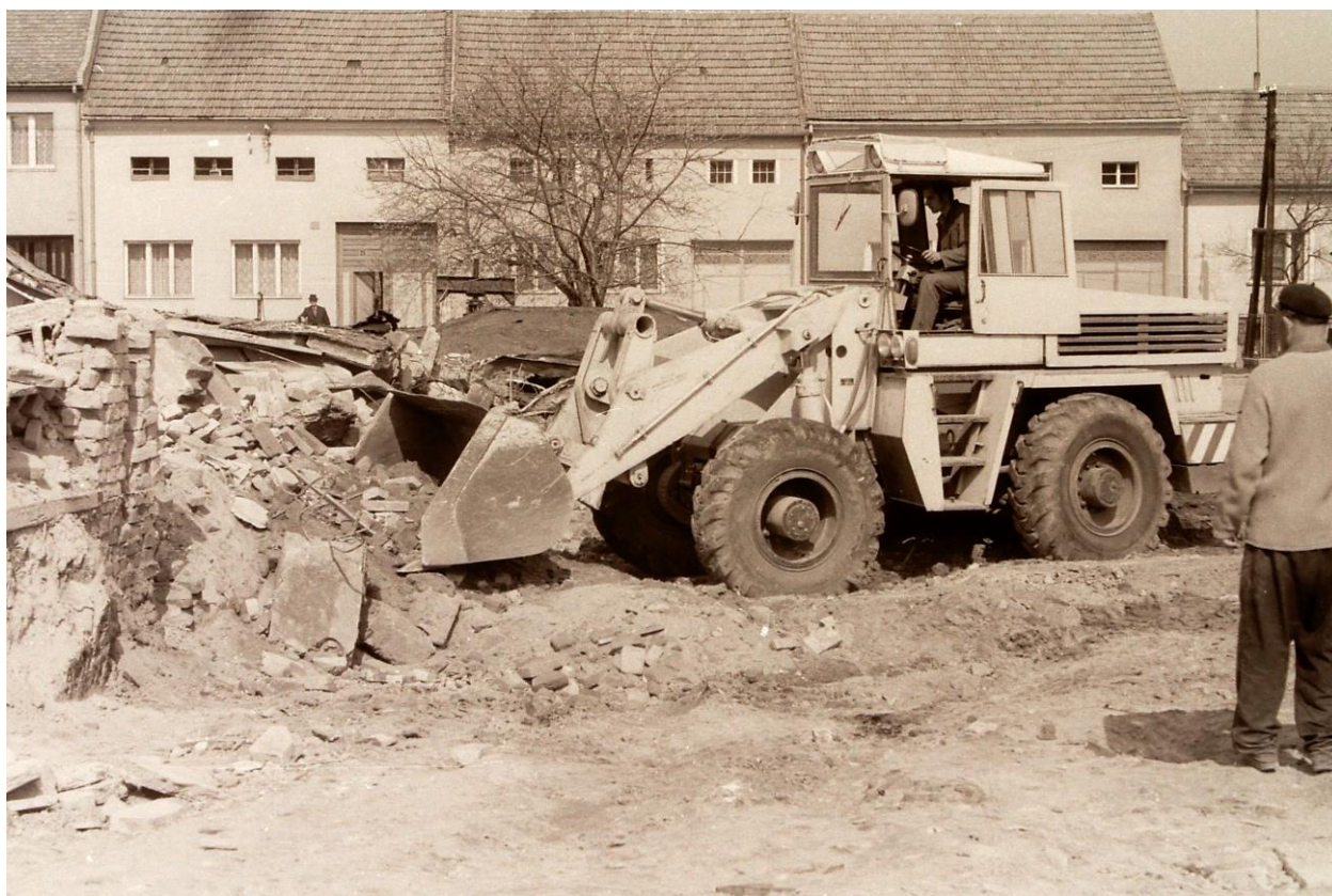
Bourání hasičské zbrojnice v dílně domu čp. 120.
