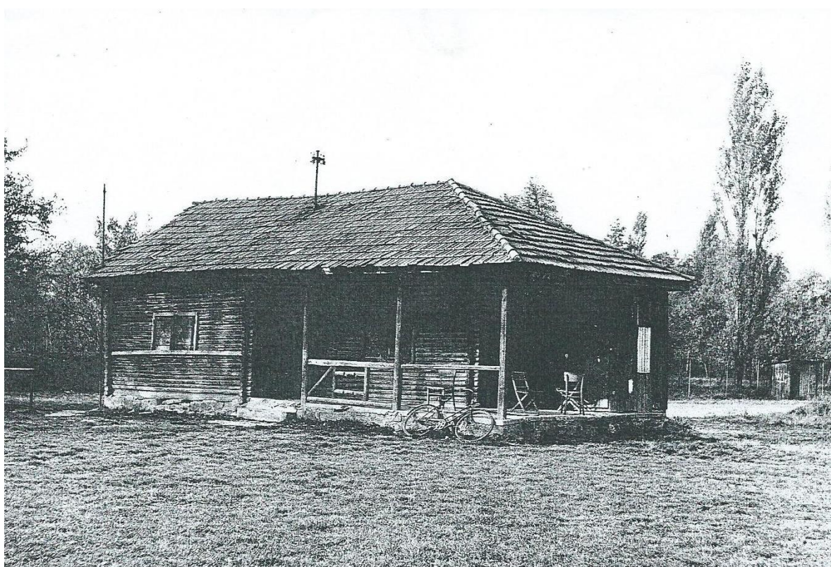
Srubová dřevěná stavba v podobě chaty postavená pro sportovce v letech 1943 – 1944, která sloužila jako fotbalové šatny až do roku 1975.
