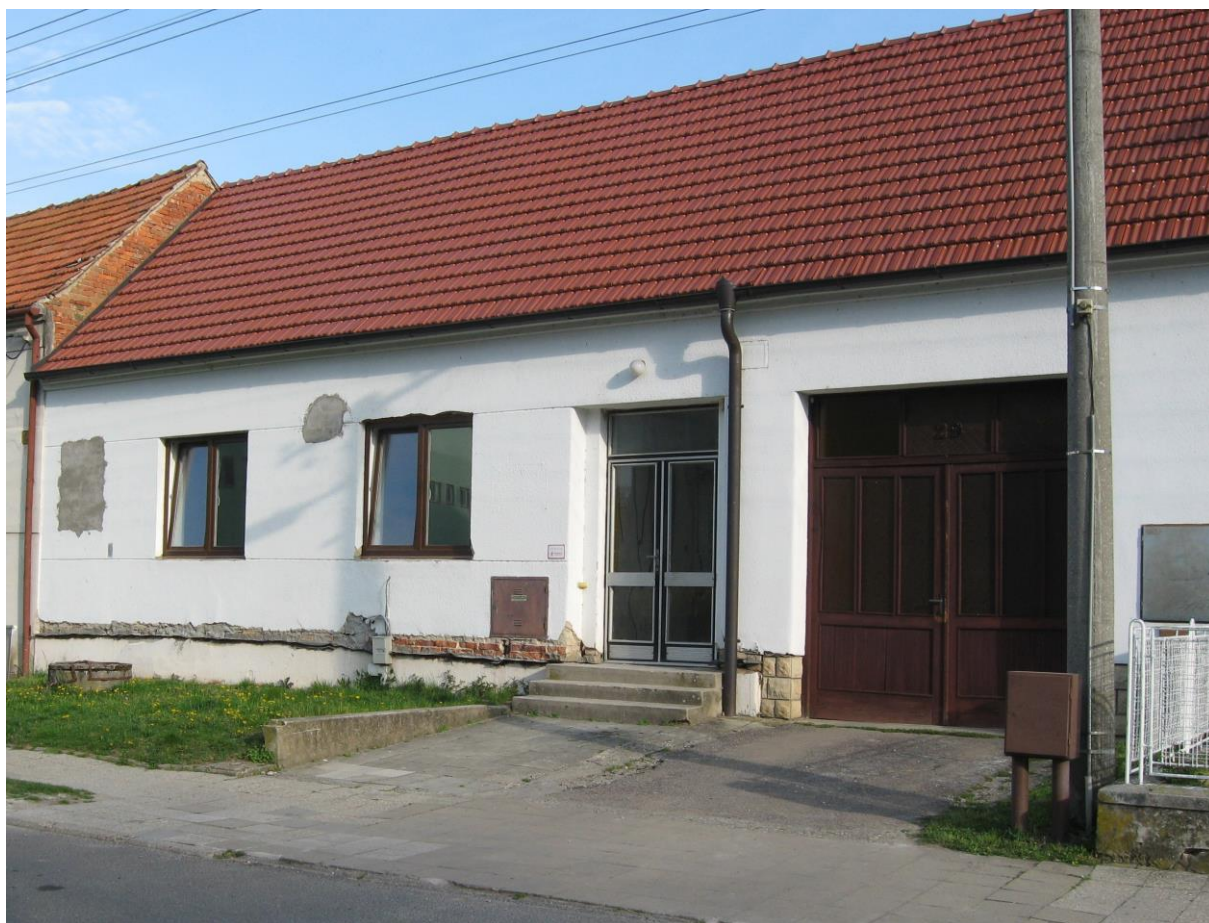
Bývalý vchod do tělocvičny a mateřské školky, zazděné okno bývalý vchod do zdravotní stanice.
