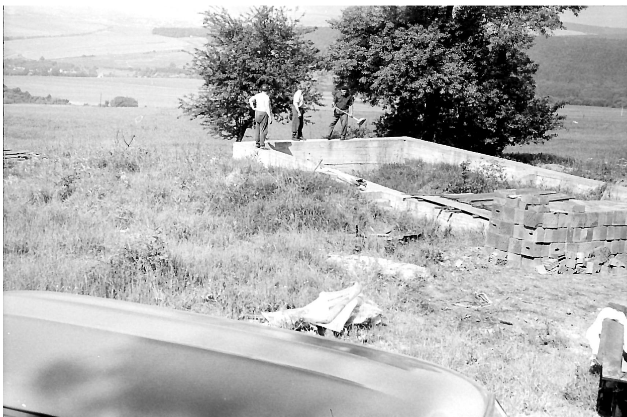
Budování základů pro mysliveckou chatu.
