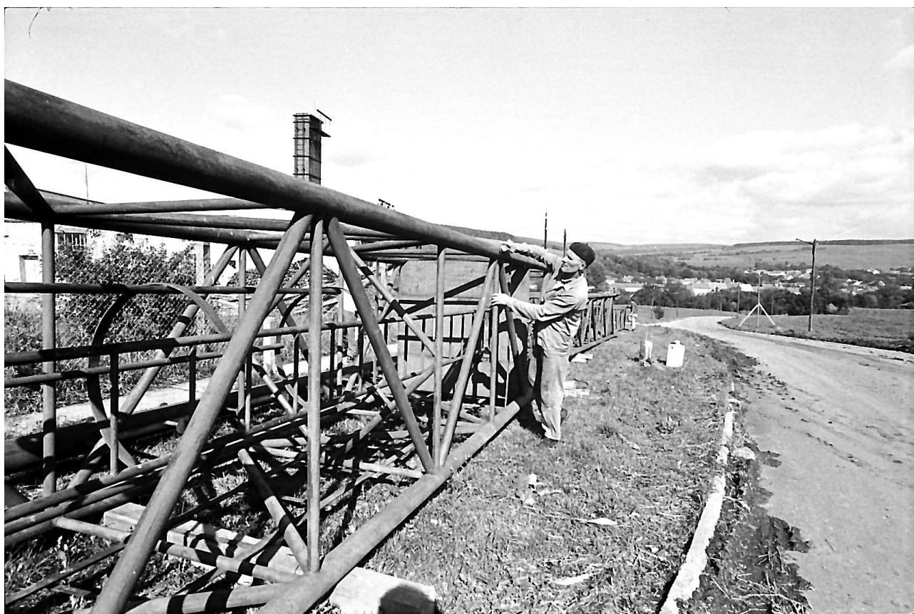
Základy a konstrukce televizního převaděče.
