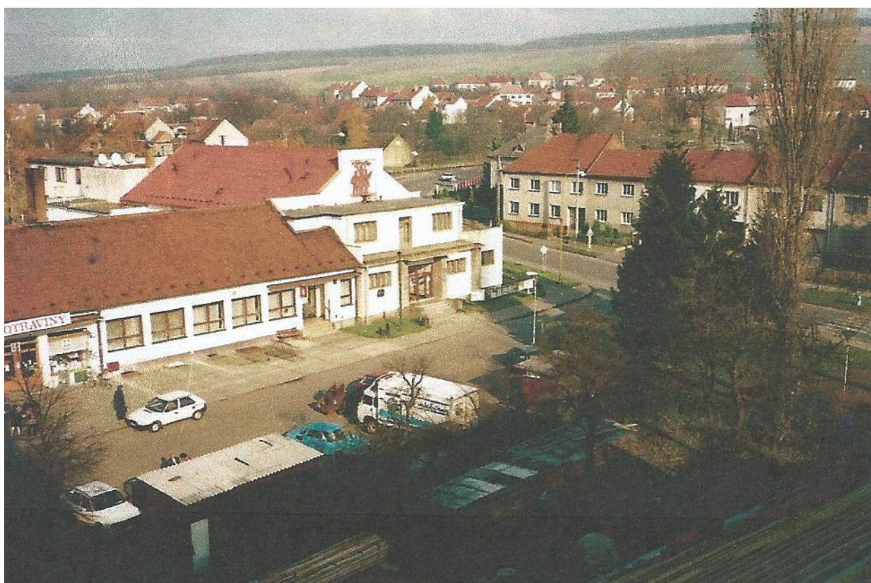
Pohled na Kulturní dům a okolí po jeho dokončení ze střechy kostela.
