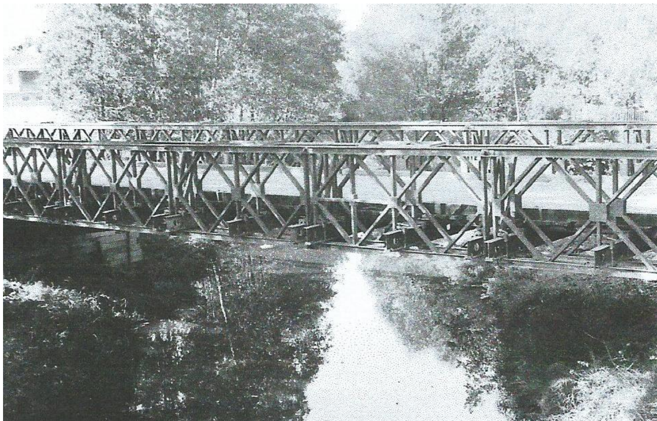
Provizorní most přes řeku Olšavu při bourání starého mostu z roku 1906.
