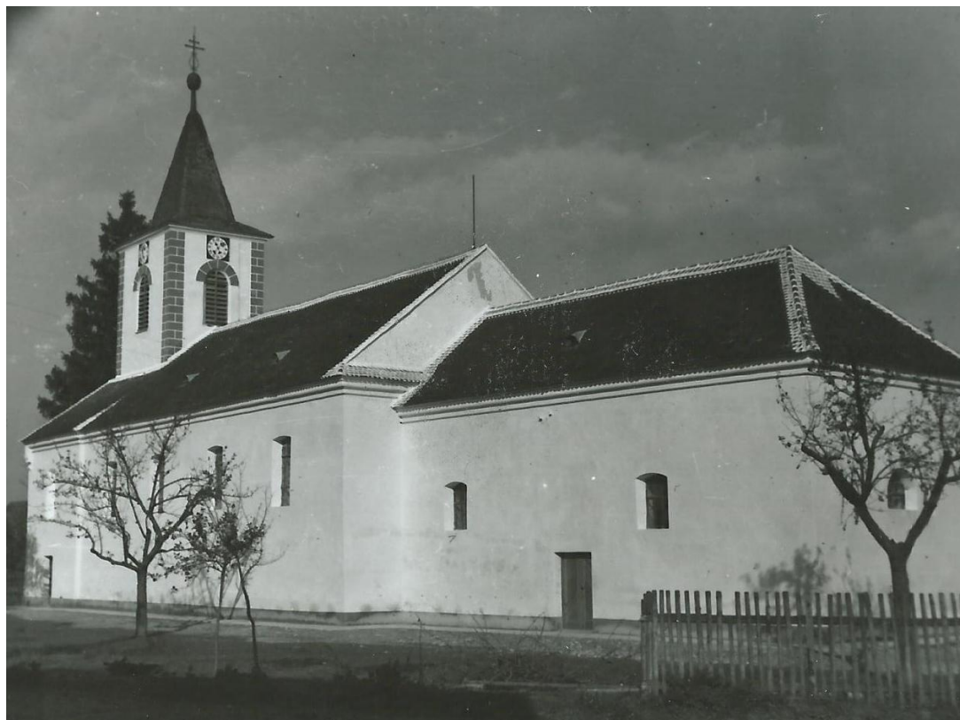
Původní stavba kostela.
