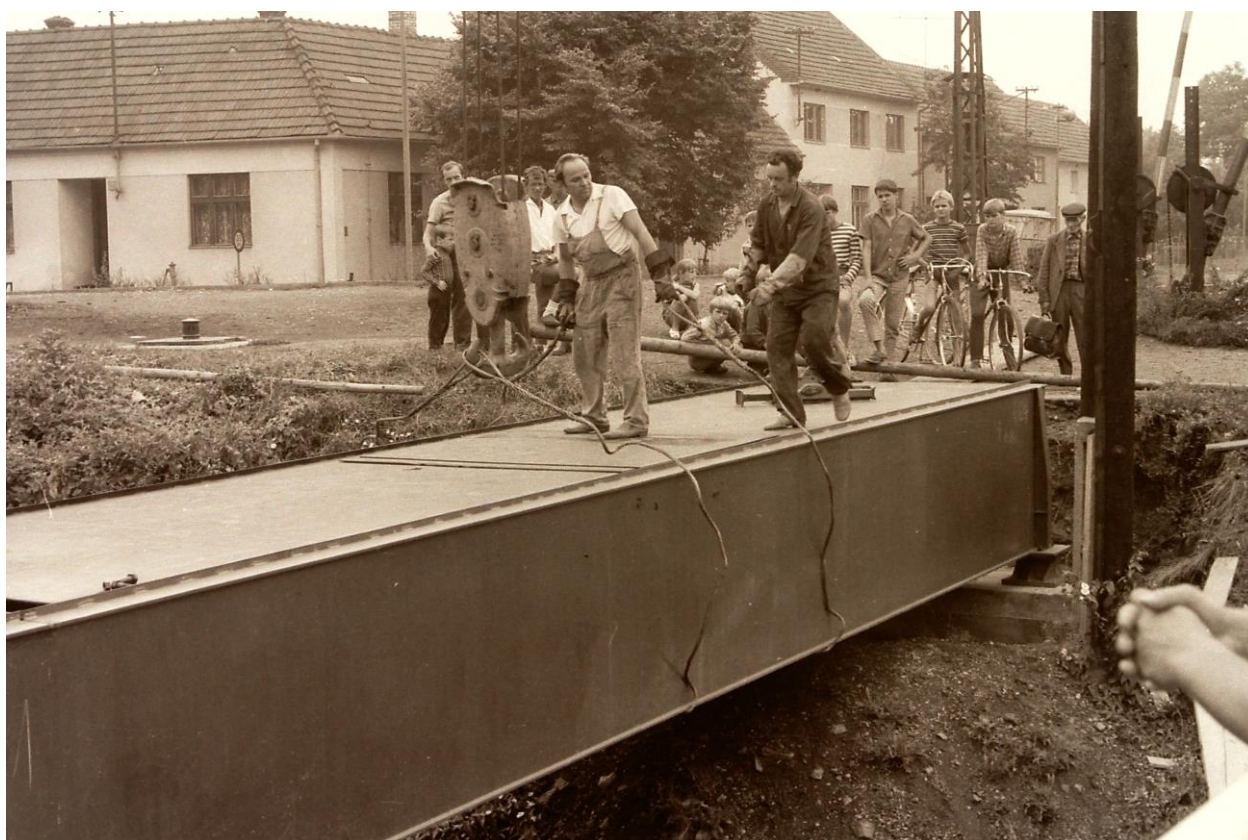
Výstavba lávky přes řeku Olšavu prováděná zaměstnanci Slovákých strojírén Uh. Brod.
