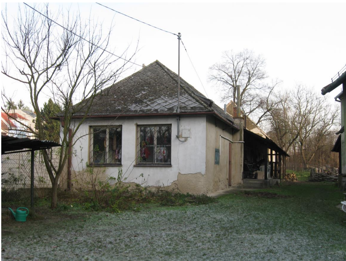
Stará pekárna v roce 1961 prádelna a další využití.
