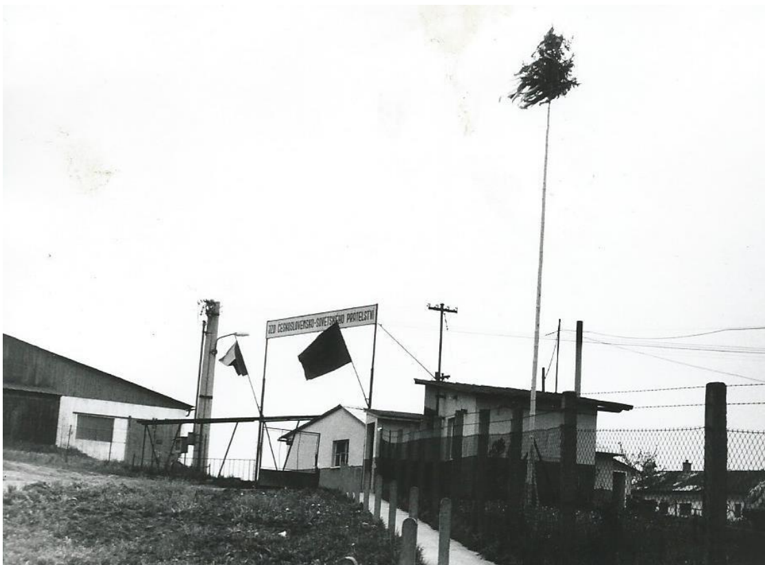
Hlavní vstup do objektu JZD.
