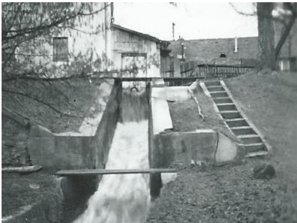
Pipalův mlýn – stavědlo s náhonem.
