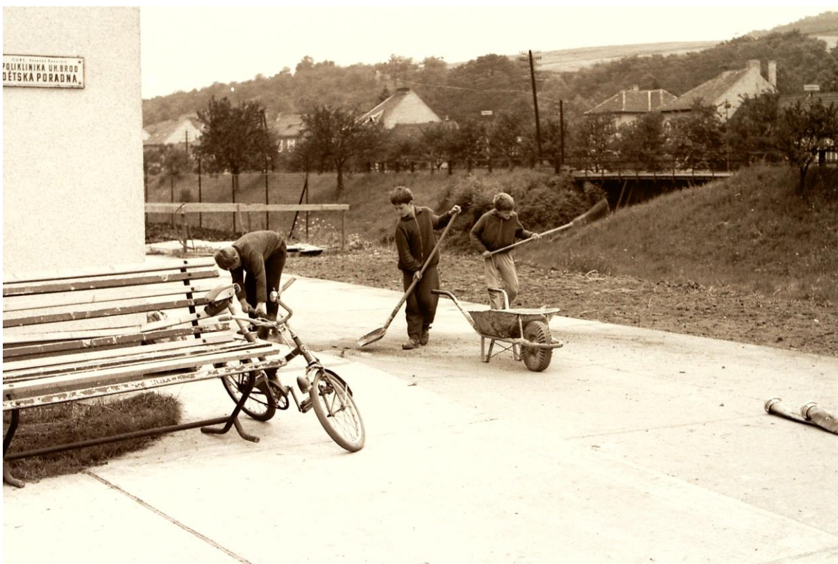
Dokončování výstavby hasičské zbrojnice za pomoci brigádníků.
