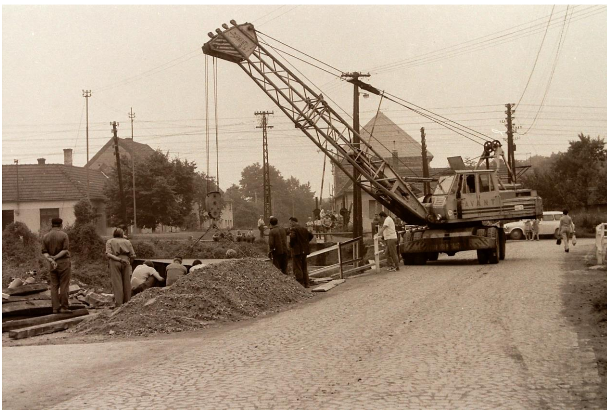
Výstavba lávky přes řeku Olšavu ze starého mostu.
