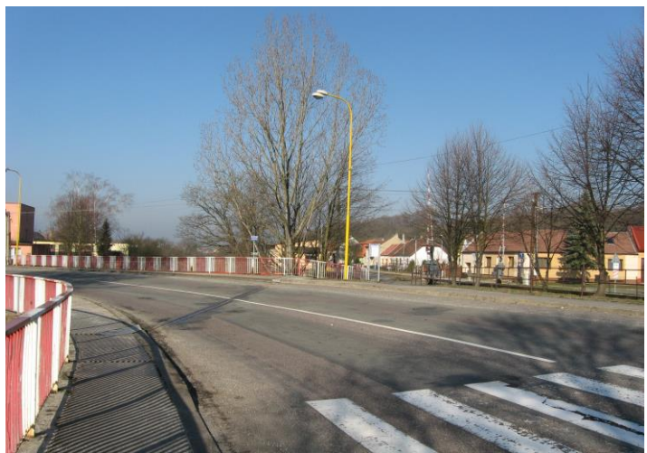
Stávající stav nového mostu.
