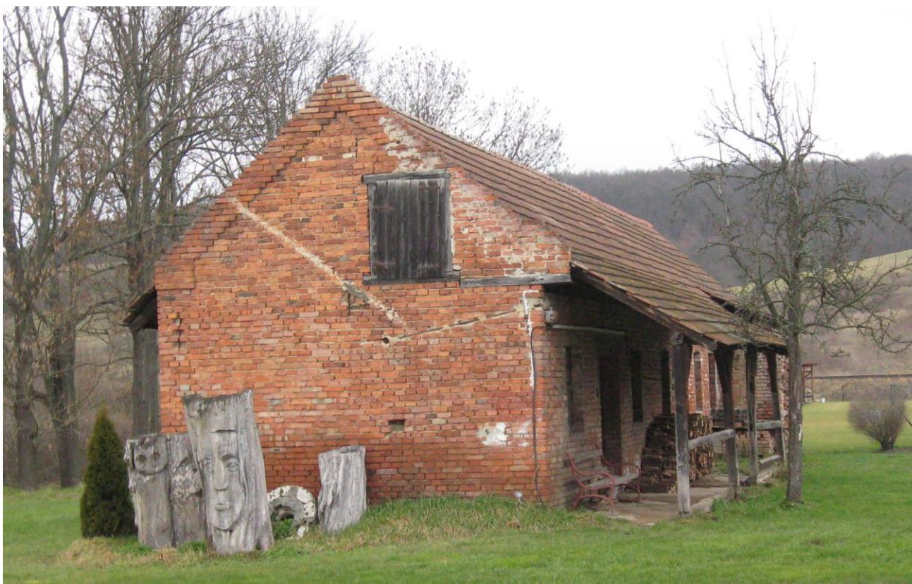
Hospodářská budova – bývalá součást Tomkova mlýna.
