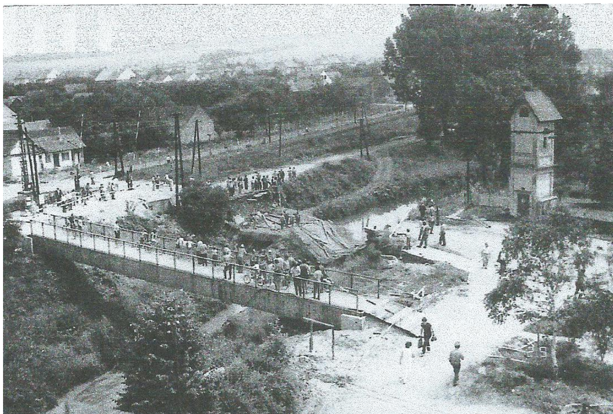
Odklizení trosek mostu.
