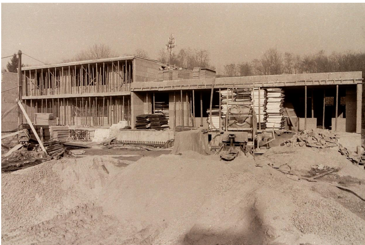
Probíhající výstavba mateřské školy.
