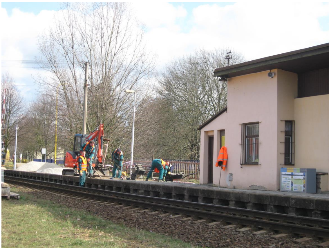
Oprava nástupiště v roce 2016.
