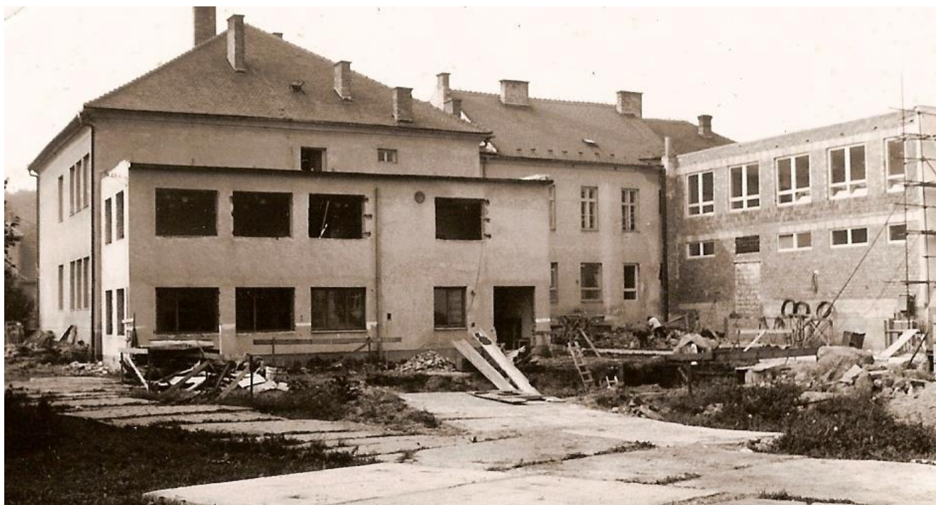
Původní část školy s jídelnou a dílnou. Vpravo nová přístavba v roce 1981.
