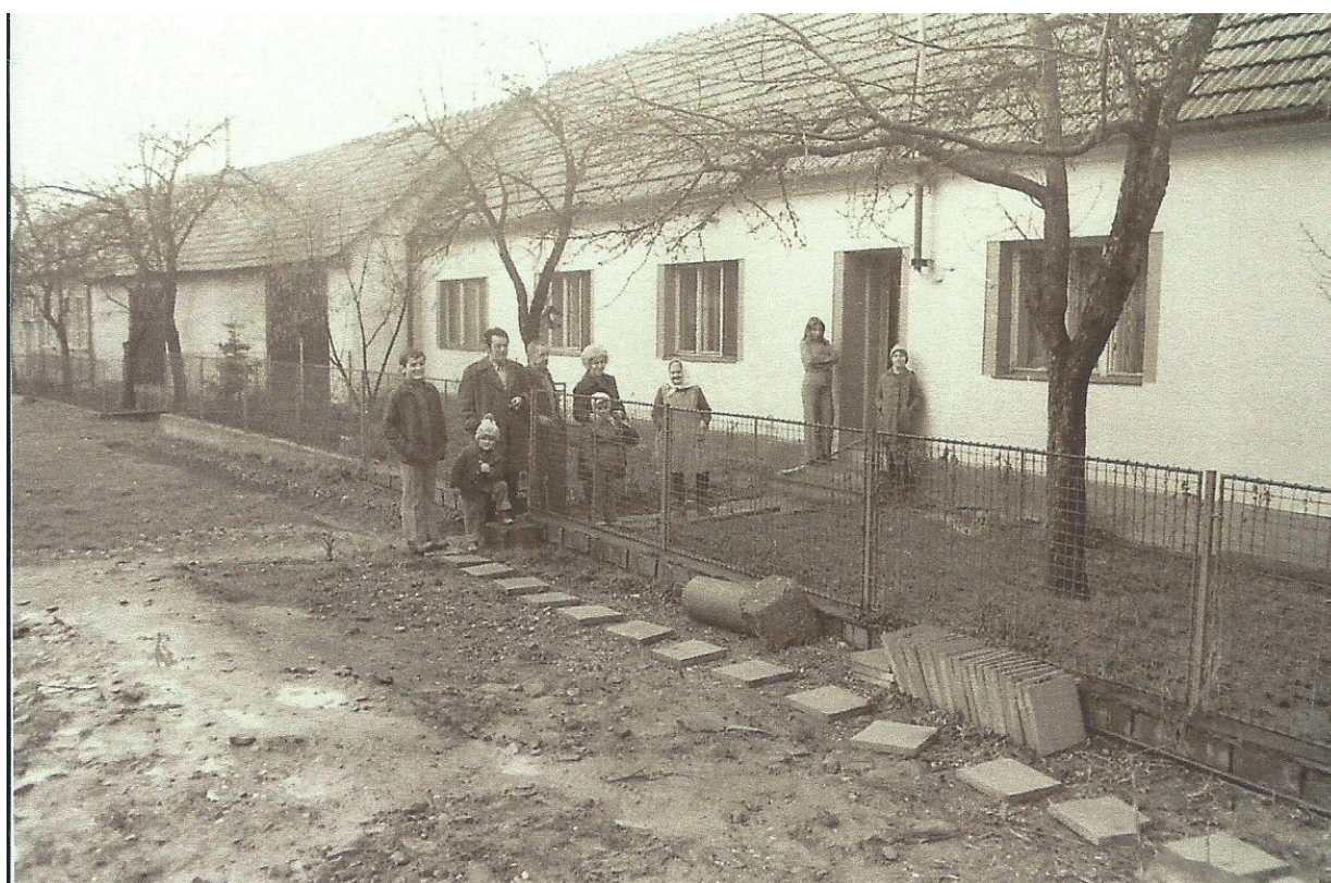
Původní domky čp. 233 Volaříkův, čp. 227 Šojdrův a čp. 120 Havlíčkův byly zbořeny a na jejich místě byla postavena nová tělocvična.
