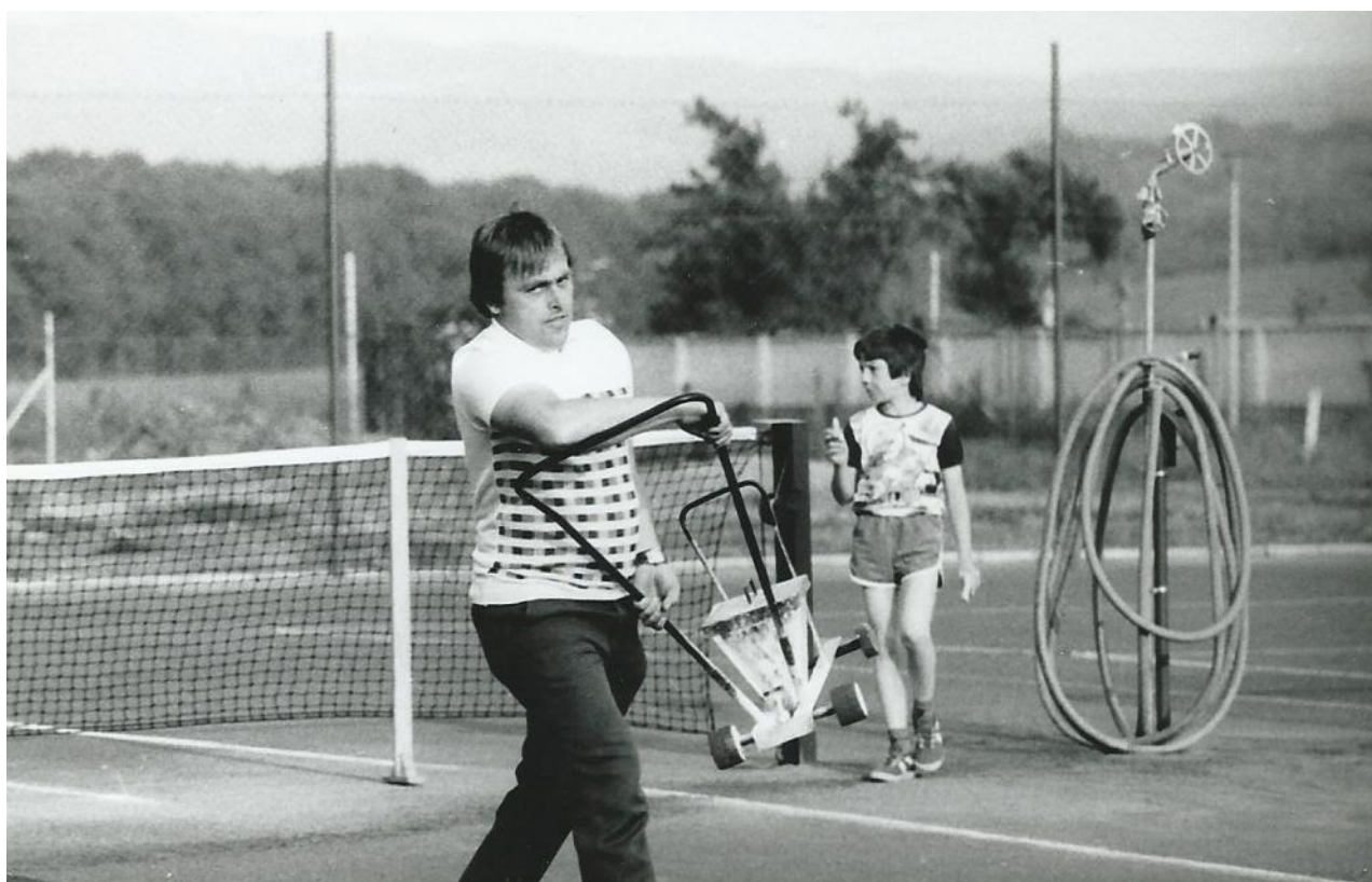
Výstavba kurtů zahájena v roce 1989. V popředí Stanislav Kořenek, jeden ze zakladatelů tenisového oddílu.
