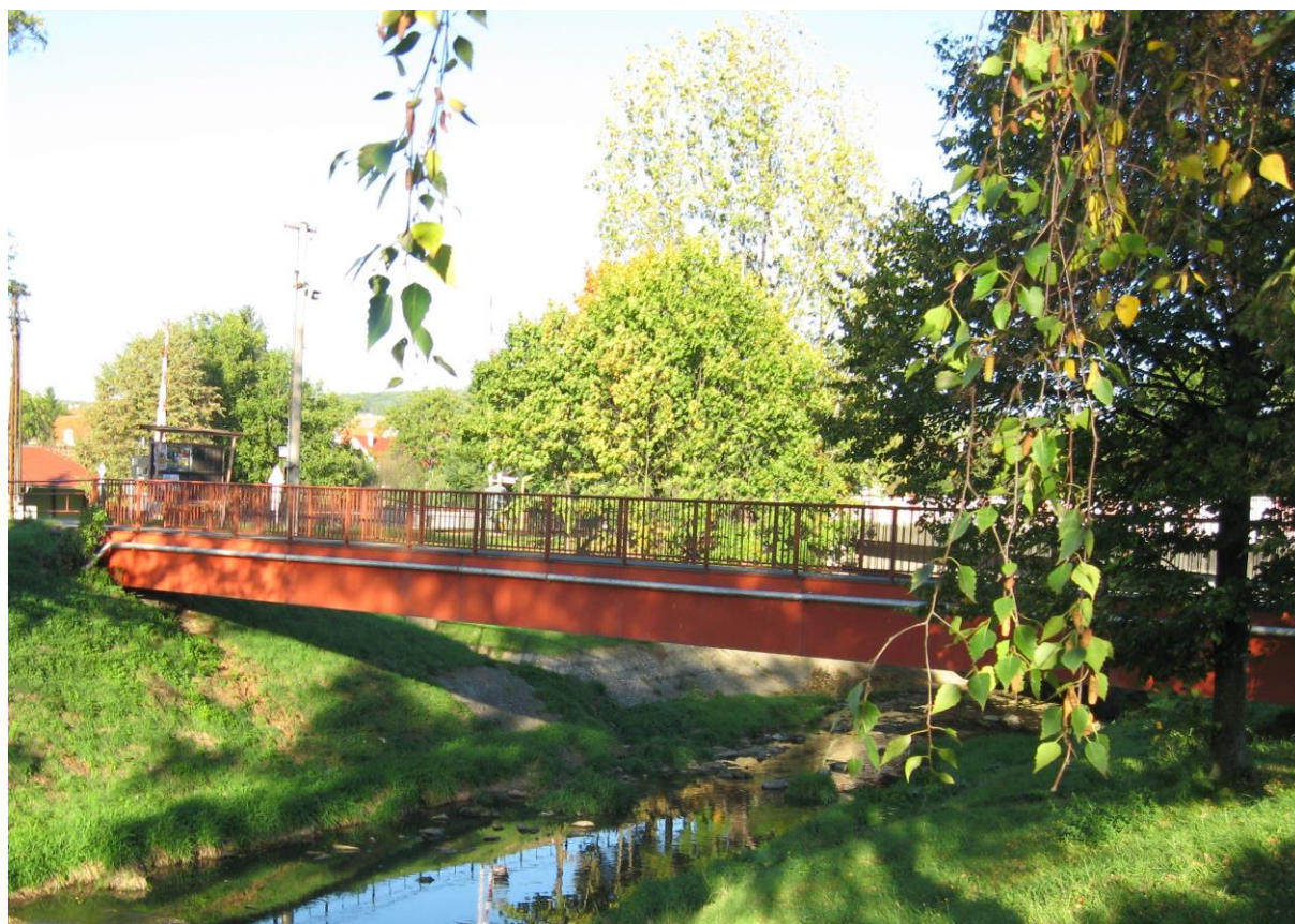
Současný stav lávky v roce 2015.
