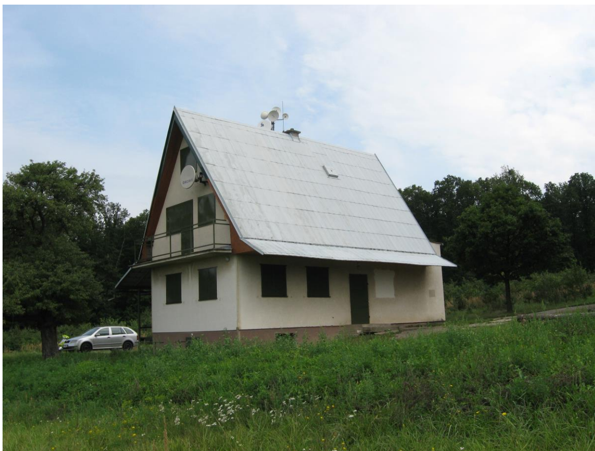
Dokončená myslivecká chata byla daná do užívání v roce 1985.
