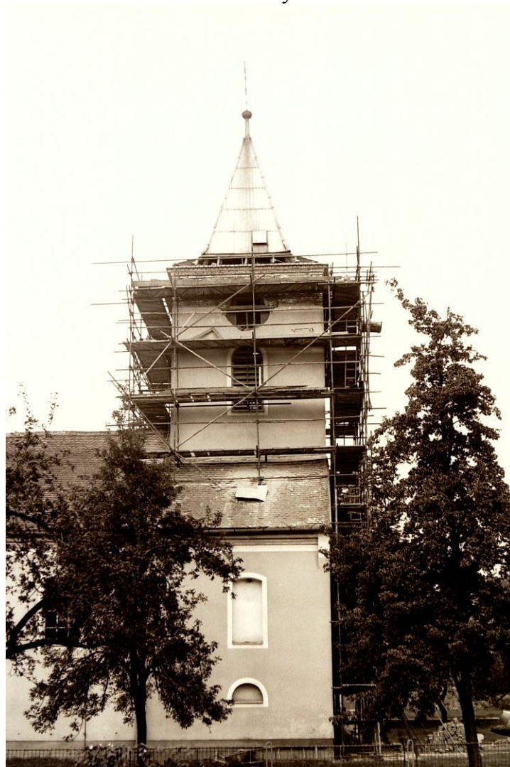
Oprava kostelní věže v roce 1966.
