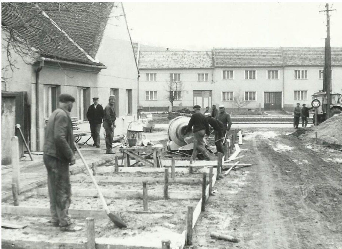
Betonování silnice k JZD.
