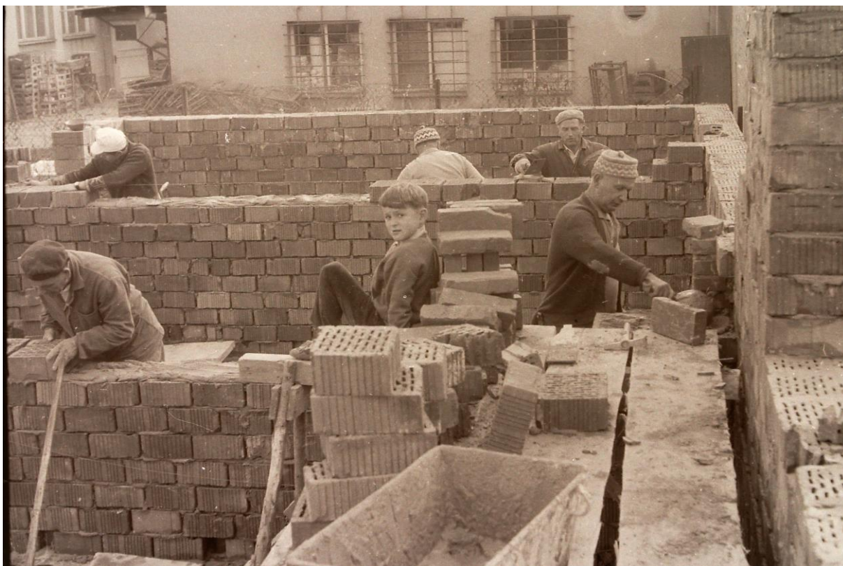
Probíhající práce na hasičské zbrojnici.
