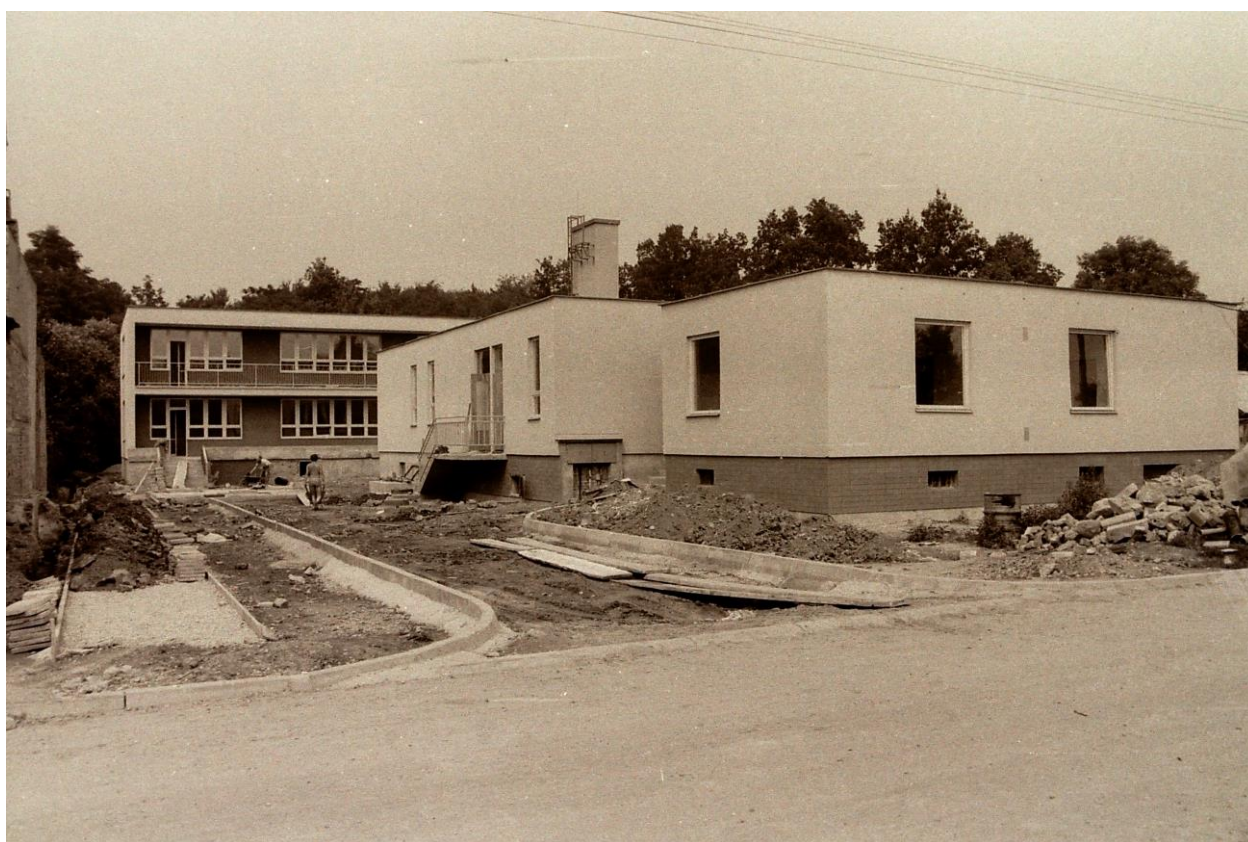
Výstavba nové mateřské školky před dokončením.
