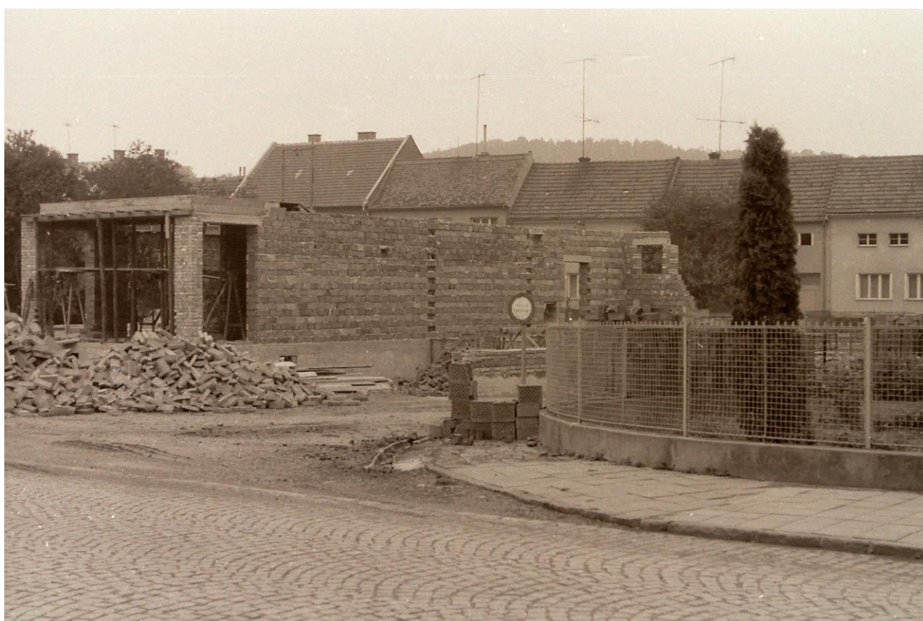
Výstavba Nákupního střediska zahájena v roce 1974.
