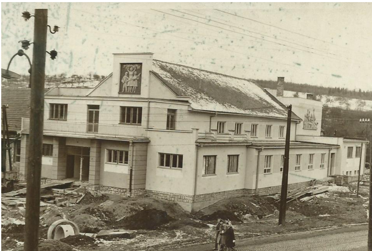
Výstavba kulturního domu v letech 1959-1962.
