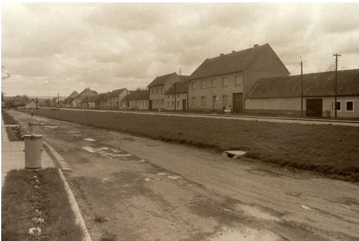
Pohled na ukončení zatrubňování.
