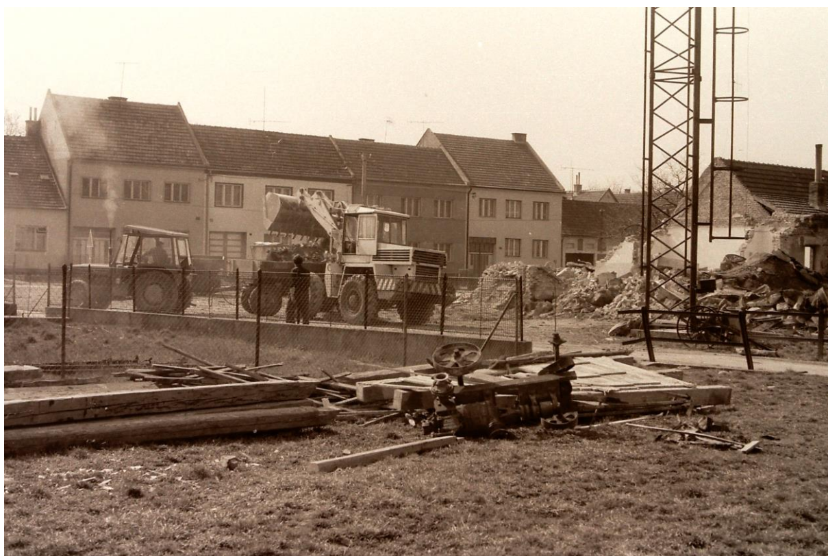
Bourání hasičské zbrojnice v dílně domu čp. 120. V pozadí domky u silnice.
