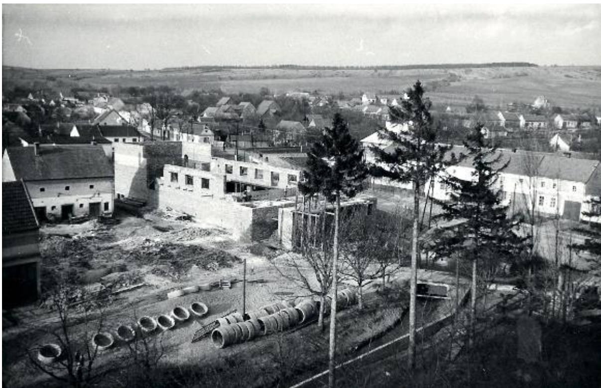
Výstavba Kulturního domu, materiál na zatrubnění mlýnského náhonu.
