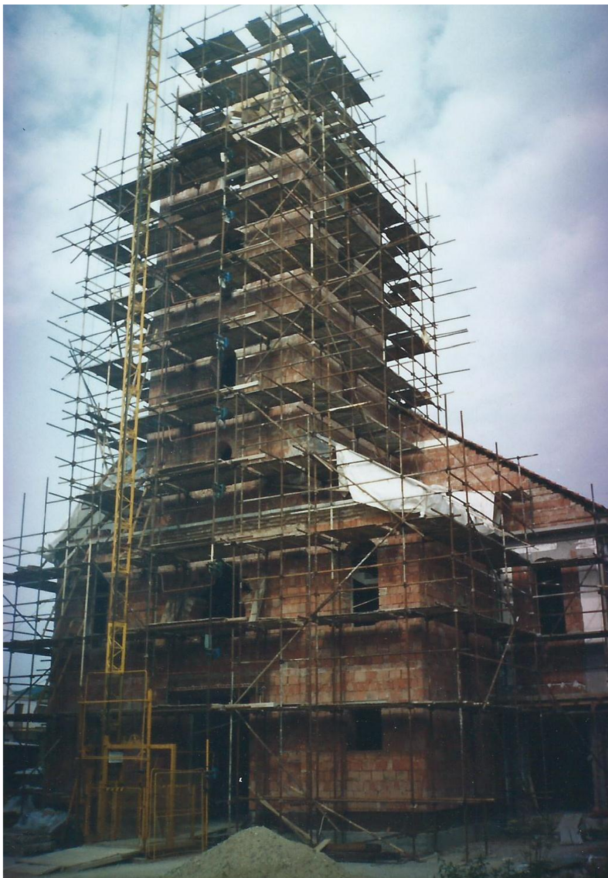
Výstavba věže kostela.
