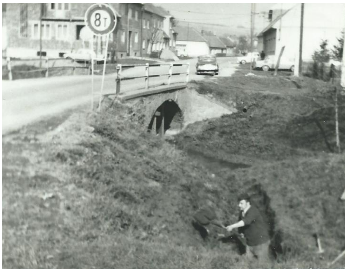
Starý silniční most přes potok Ledské na začátku vesnice směrem od Uh. Brodu.
