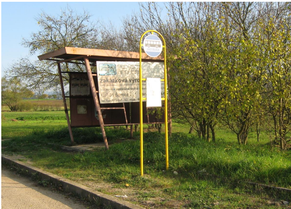
Původní krytá autobusová zastávka.
