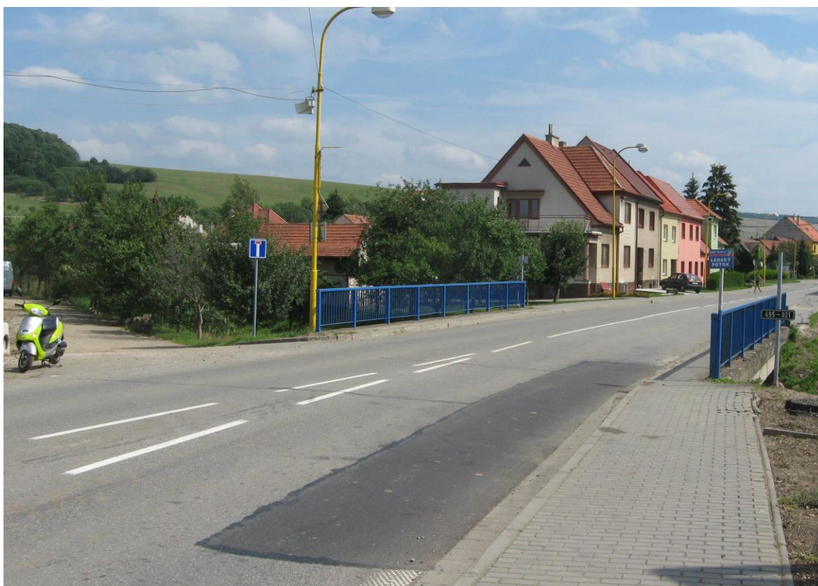
Nový silniční most přes potok Ledské.
